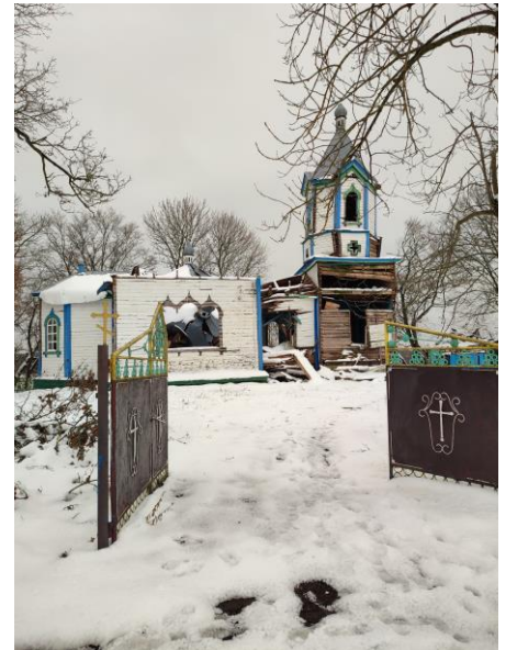
Напівзруйнована церква Різдва Пресвятої Богородиці, с. В'язівка (Житомирська обл.). Фото Антона Лещинського, 27 листопада 2022.
